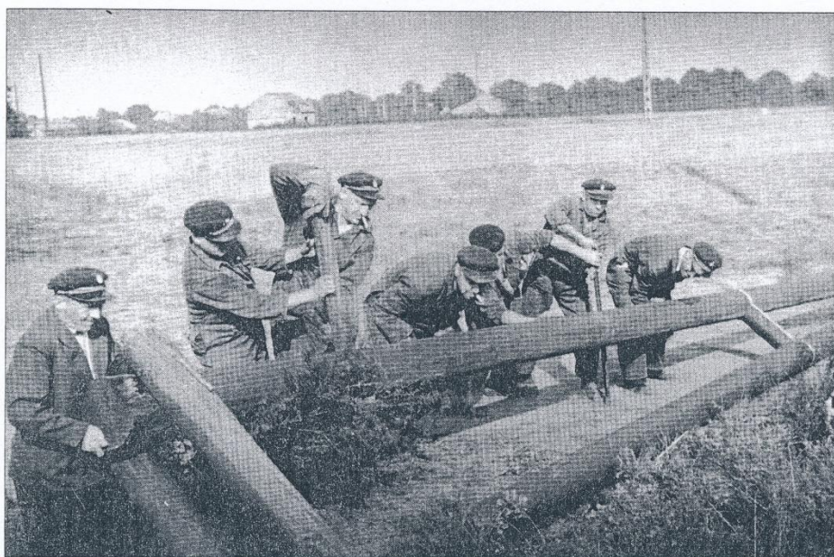
Een ploeg van Interelectra aan het werk bij het plaatsen van een zogenaamde "A-paal", de opvolger van wat Henri een "zjubilé" noemt.
